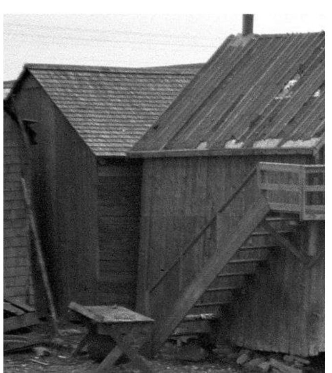
Revêtement petits bâtiments, 1944 (BANQ)
