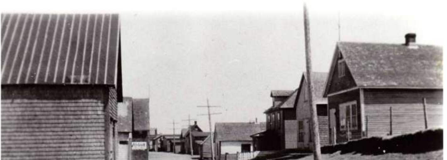
Entrée du site (source Musée de la mer). À droite, les quatre premiers bâtiments témoins.
