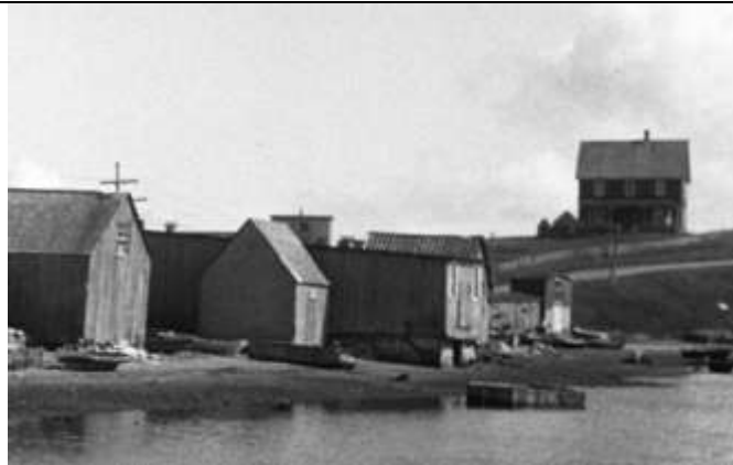
Détail petits bâtiments, côté intérieur. Bout de la Grave.1944 (BANQ)
