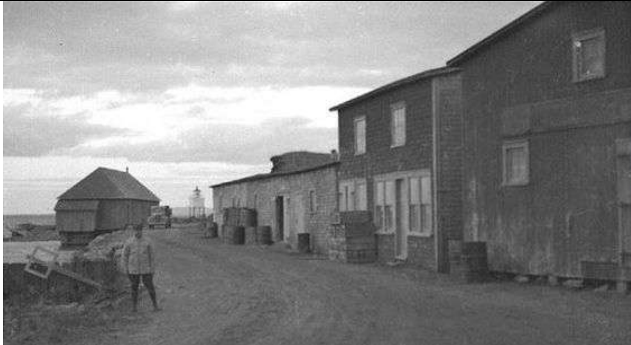
Chemin de l'ancien quai en 1944 (BANQ). Variété de volumes, formes, ouvertures.
